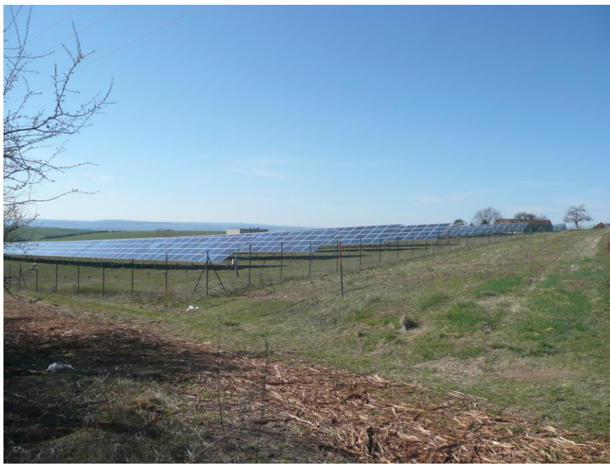
Solární elektrárna v obci Dřínov
